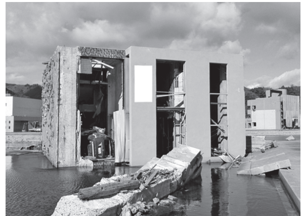
写真-1 建物の転倒被害例
