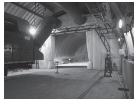
写真一4 隔離壁車両通行部 開
