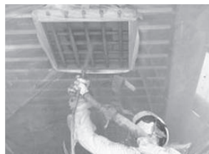
写真一4 試験状況
