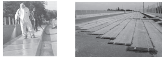
写真一7 塗膜系およびシート系防水システムの施工例
