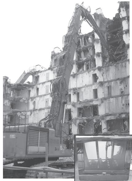
写真一４ 大型解体用機械の遠隔操作実証実験
