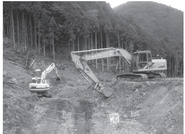
写真-3 防護土堤作成工事
