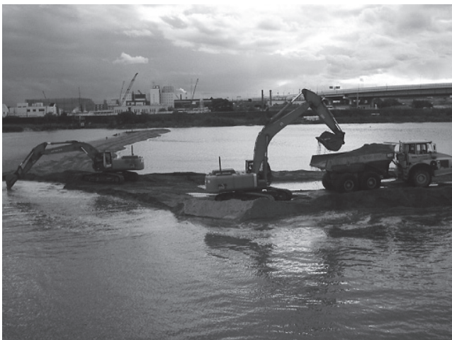
写真-2 大和川河道掘削工事
