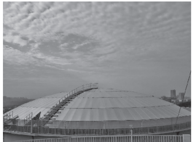
写真一 3 アルミドーム屋根外観
