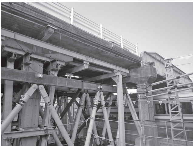
写真一五 既設跨線橋と仮設トラス桁
