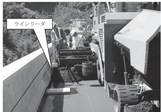
図-12 ラインリーダーによる施工例
