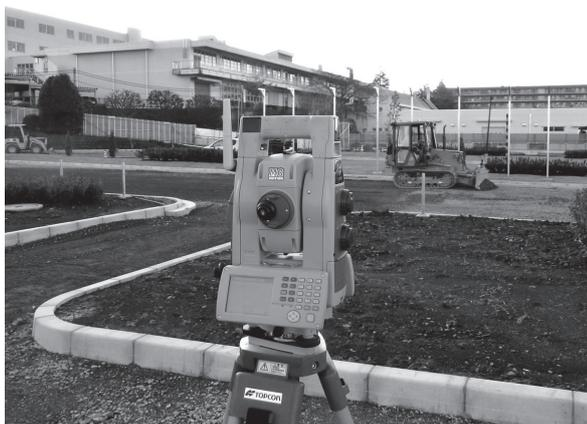
図一2 TS式3D-MC小型ブルドーザによる施工
