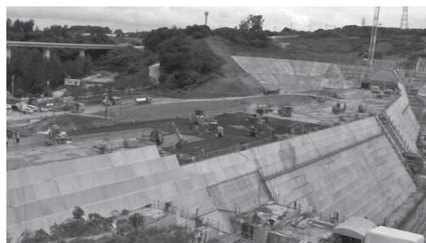
図—1 億首ダム施工状況
