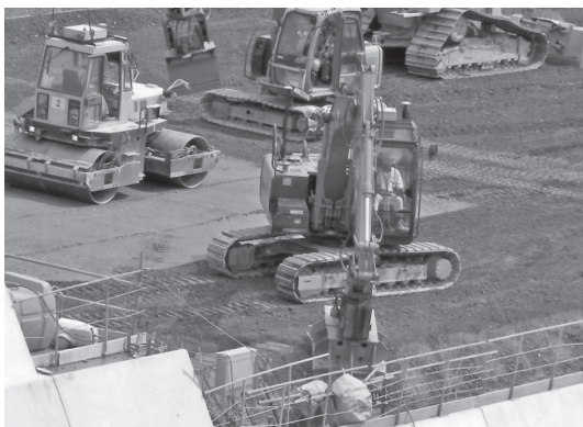
図一 13 端部法面締固め実施状況
