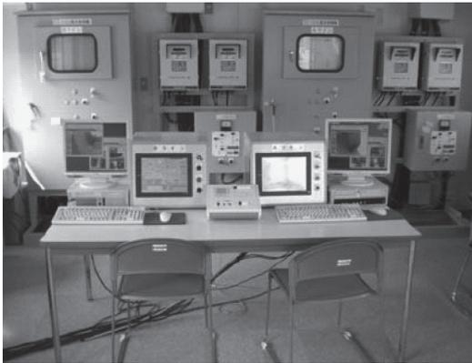
写真—4 CSG 製造総合監視システム
