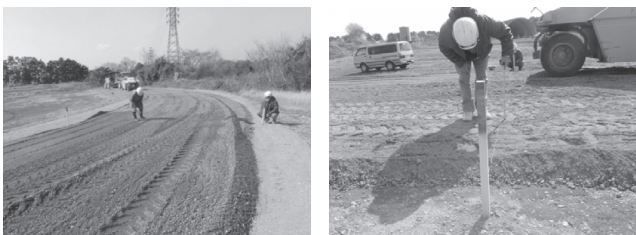
写真一3 現行の敷均し高さ管理
