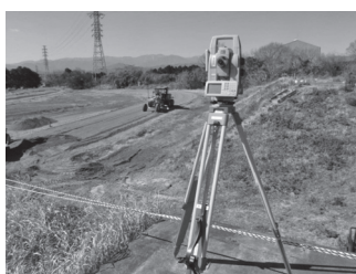
写真一4 MCによる敷均し高さ管理
