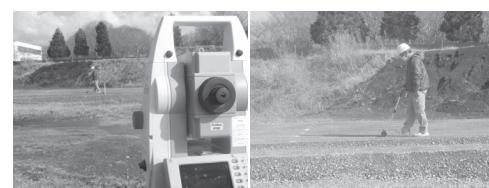
写真二 2 新たな管理基準による出来形管理（路盤工）
