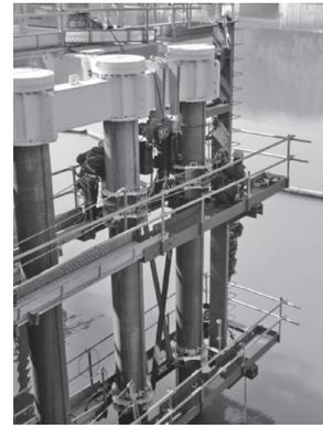
写真-1 プレース材組立て状況
