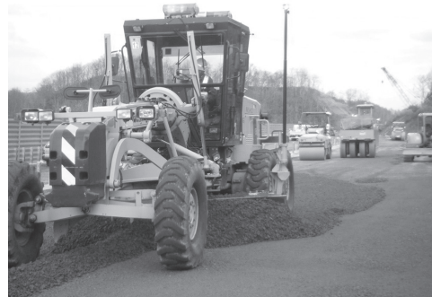
写真-1 ICT施工による車道路盤工敷均し状況
