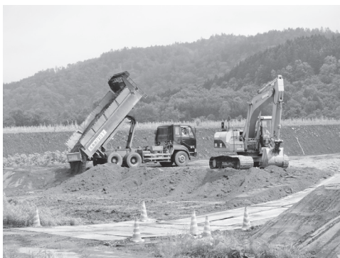
写真一三 脱水ケーキを利用した盛土の施工状況
