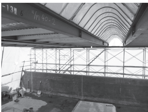
写真一四 パネルを用いた防寒養生の状況
