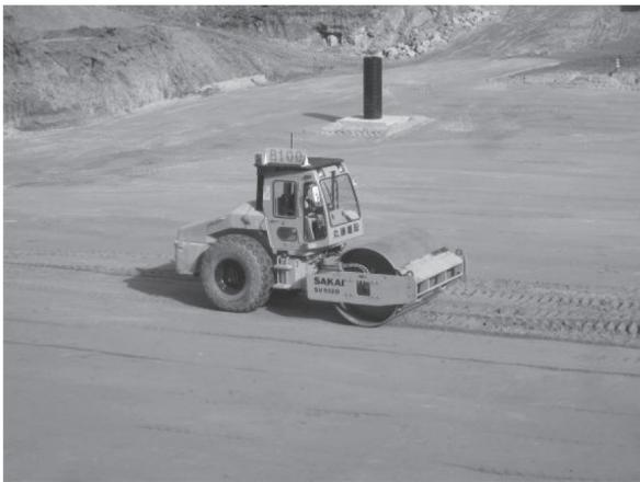
写真-5 B100 で稼働する振動ローラ
