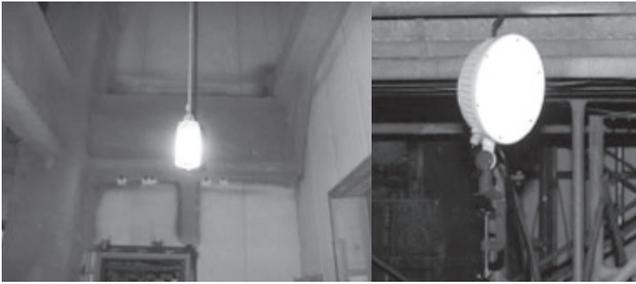
図-9 電球型 LED 照明 (左) と投光器型 LED 照明 (右)
