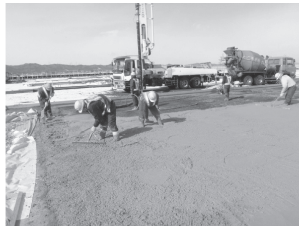
写真一2 打設状況
