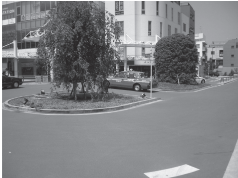
写真一 4 駅前ロータリーでの施工例
