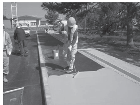
写真—2 遮熱性舗装の施工 (a) MMA系2液硬化型、(b) 水系1液型
