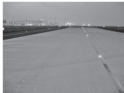
写真—3 空港誘導路での施工例(成田国際空港)
