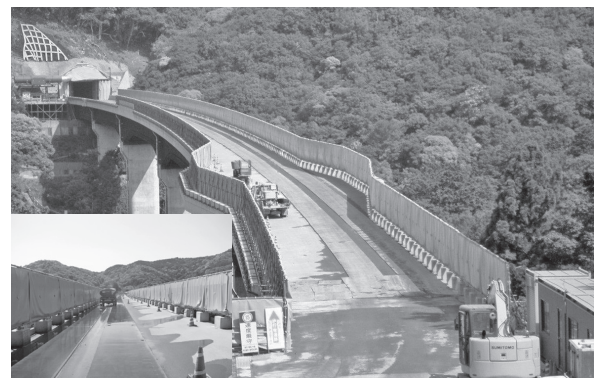
写真— 14 防音シート
