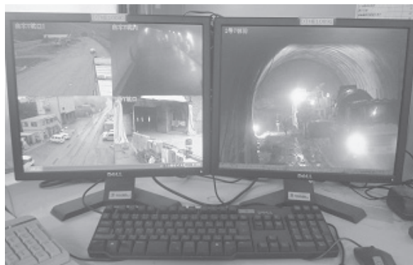
写真一〇 WEB動画監視システム
