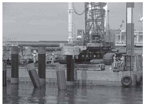
写真一4 低減装置付き油圧ハンマによる打設状況(直江津)
