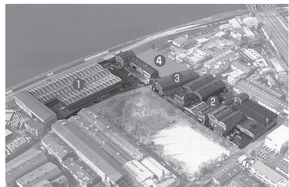
写真一 ①竹島第一工場 ②竹島第二工場 ③竹島第三工場 ④竹島ヤード 航空写真
