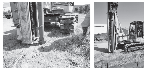
写真-1 ケーシング、先端ビット及び削孔状況
