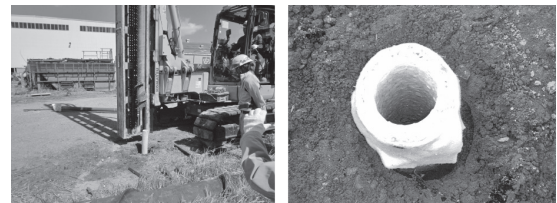
写真-2 ドレーン材の埋設完了状況
