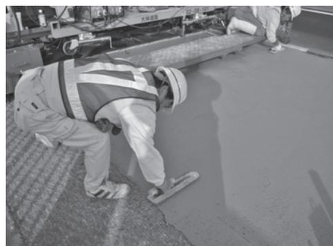
写真-3 端部仕上げ状況
