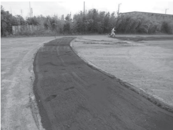
写真-11 グラウンド 曲線部分の施工
