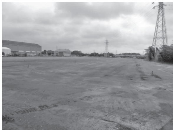
写真—14 グラウンド 施工終了後の状態
