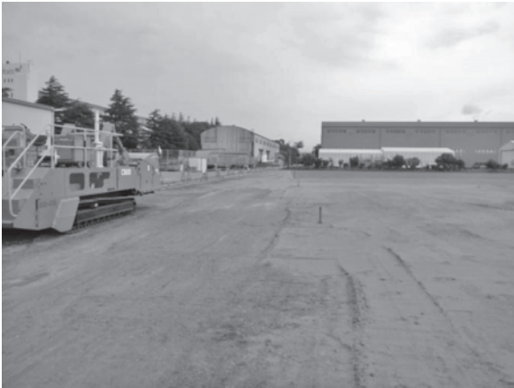
写真-9 グラウンドの施工現場
