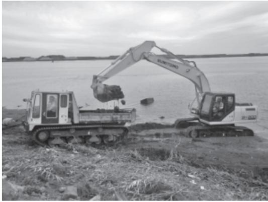
写真一五 クローラダンプによる浚渫土の運搬
