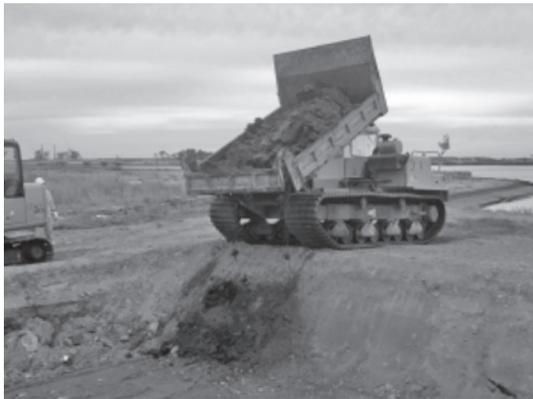
写真一六 土砂ピットへの浚渫土の投入
