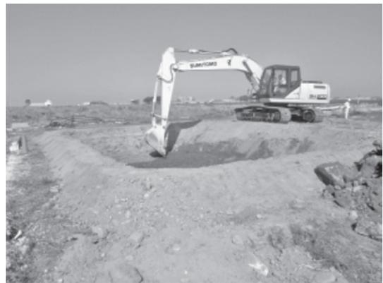
写真—4 土砂ピットの掘削
