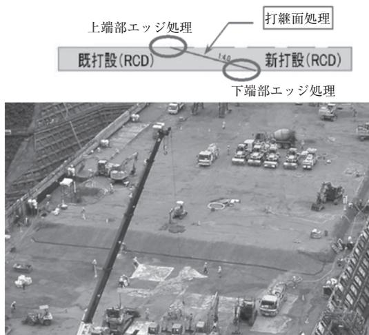
写真—4 傾斜打止めの施工状況
