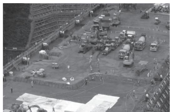
写真一 三 1:0.8 端部法面による打止め施工状況
