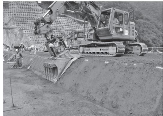
写真一 二 端部法面締固め状況
