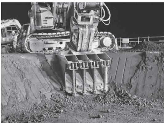
写真-6 入隅部の締め固め状況
