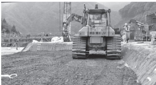
写真—5 1:0.8 端部法面打継ぎ施工状況 (ブル転)
