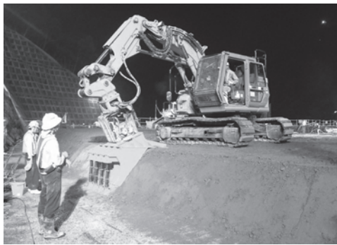
写真—4 1:0.8 端部法面締固め状況
