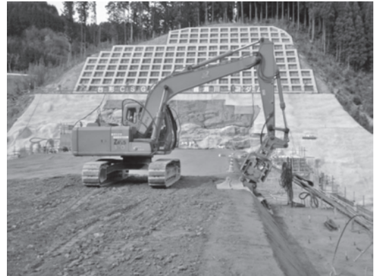
写真一八 法肩締固め機施工状況
