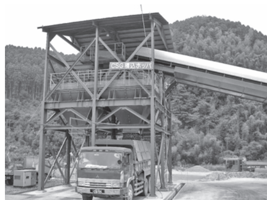
写真一 3 積込ホッパからの積み込み状況
