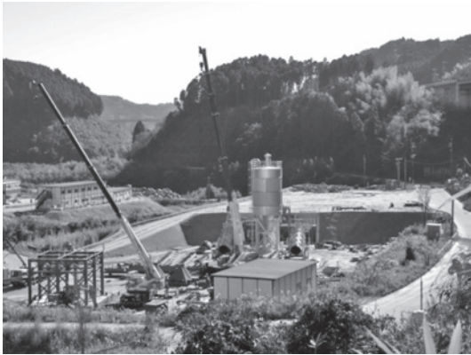
写真一七 設備の組立状況
