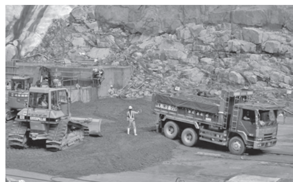
写真一 4 堤体への運搬、数均し施工状況
