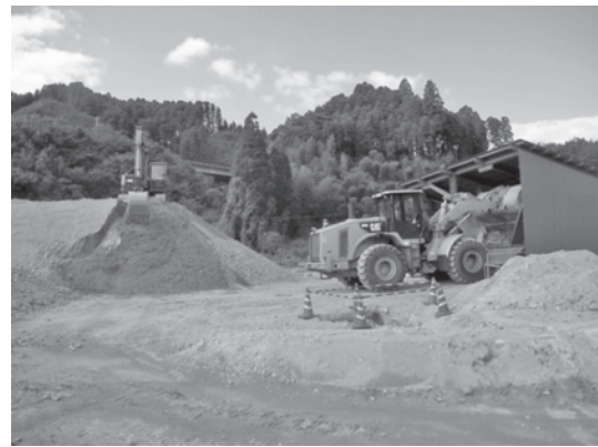
写真一 1 CSG 材ホッパ投入
