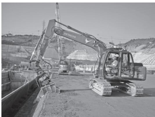
写真一 2 端部法面締固め実施状況
