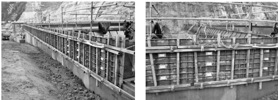
図一四 ダム・コンクリート工事現場へのセンサ搭載型枠の試験導入事例
