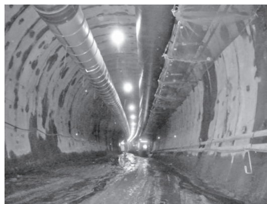
写真一1 ベルコン設置(掘削完了部)
