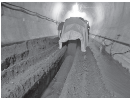
写真-4 トレンチャー掘削
