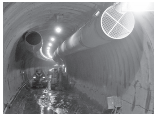
写真一三 伸縮ダクト設置
