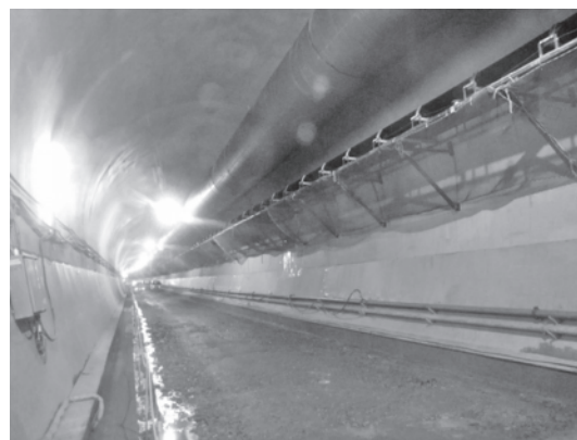
写真一2 ベルコン設置(覆工完了部)
