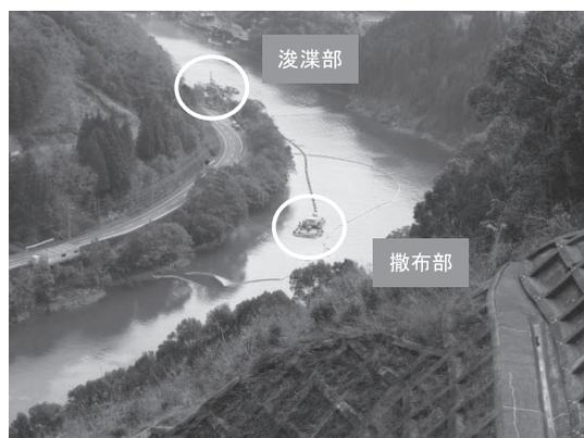
写真一 8 貯水池内移動工法による試験工事
