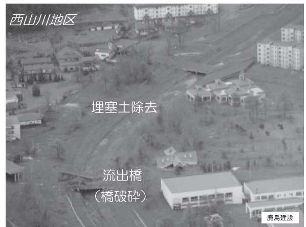
図-25 西山川地区の被災状況
