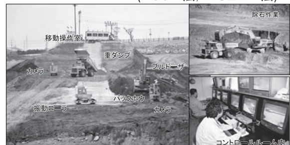
図—4 無人化施工技術の活用拡大(警戒区域内の砂防施設構築)
