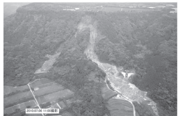
写真-3 鹿児島県南大隅町の被災状況(平成22年)
