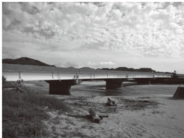
写真一 2 新設時から塗装した府屋大橋 新潟県国道7号 1982年から30年間を経過して現在も観察中
