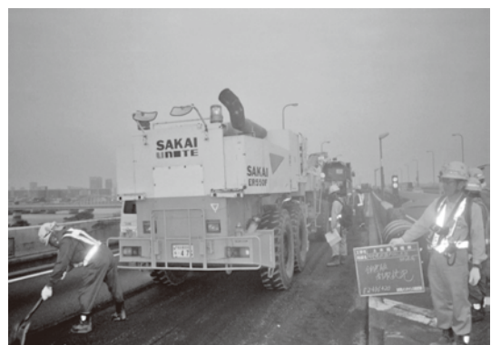
写真—1 路面切削機
