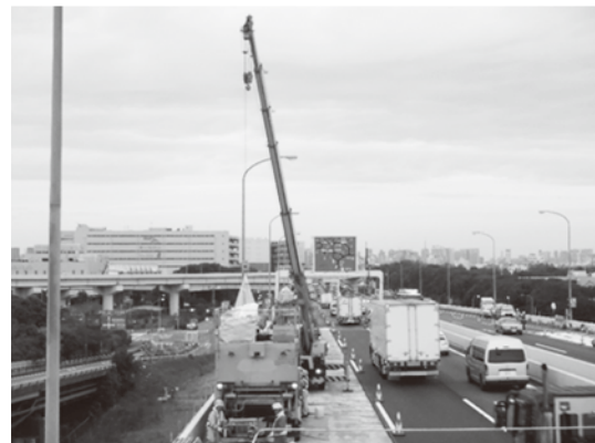
写真一7 移動式バッチャミキサ車への材料追加搬入
