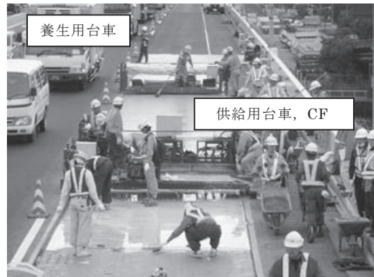
写真一8 HFRC 打設状況
