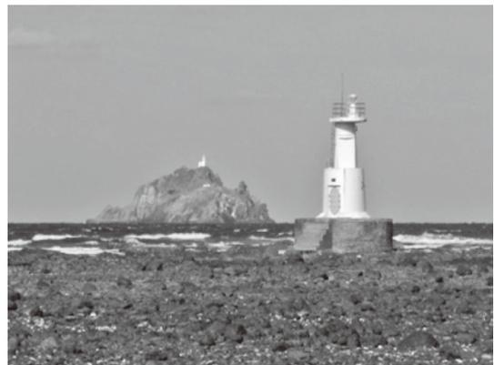
写真—1 海水と未洗浄の海砂を使用した肥前長崎鼻灯台（手前の灯台、海上保安庁佐世保海上保安部ホームページより転載、<http://www.kaiho.mlit.go.jp/07kanku/sasebo/>）
