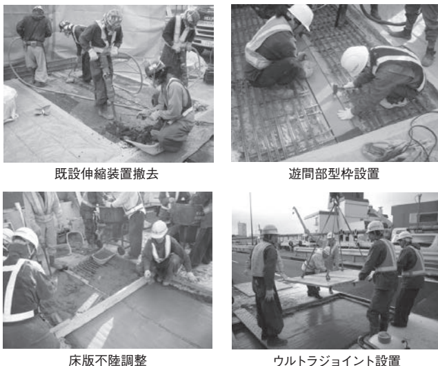
写真-3 各工程の作業状況
