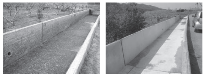
写真-7 施工前および施工後の状況
