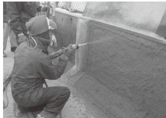
写真-6 ECC吹付け状況
