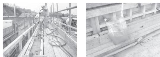
図一14 コンクリートの施工と初期排水状況
