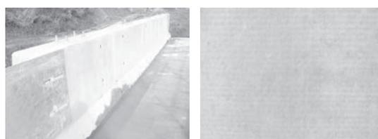
図一15 脱型後のコンクリートの仕上がり状況
