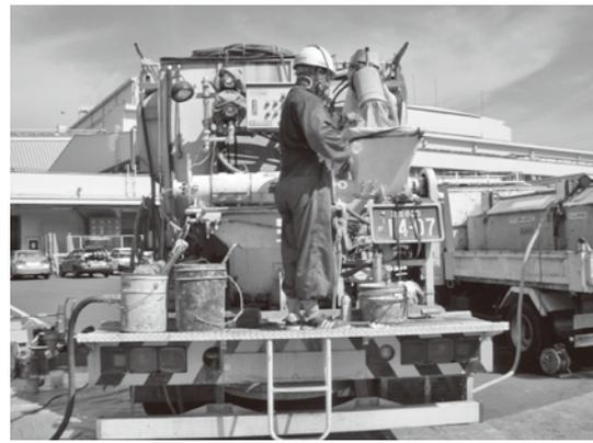
写真—5 連続鍊りローリー車によるセメントミルクの製造
