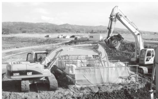
写真一3 浜尾遊水地における施工の様子（写真右のバックホウで高含水比の原泥を掘削しピットに入れ、左のバックホウのアタッチメントを攪拌用のミキサーに変え、古紙と原泥を混合・攪拌する）
