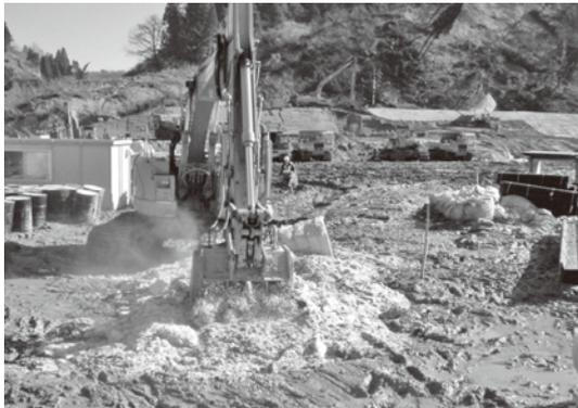
写真一7 土砂災害により発生した大量の軟弱土に古紙破砕物を混合している様子。処理土は強度発現が早いので、迅速な復旧工事に大きく寄与した。
