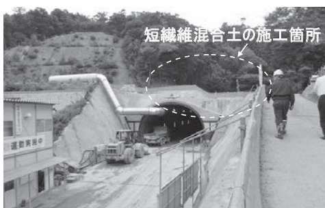
写真—16 トンネル坑口地盤の靱性強化
