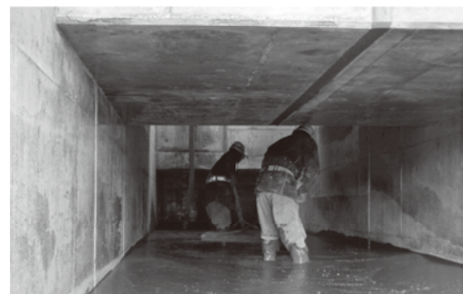
写真一九 気泡混合土の打設状況
