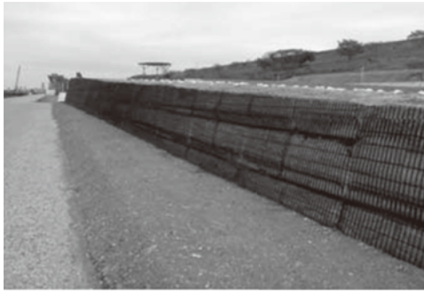
写真一六 ジオグリッドによる法面補強
