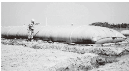
写真—3 袋詰脱水処理工法
