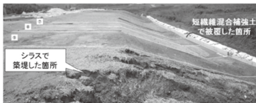
写真—14 シラスを用いた短繊維混合補強土（施工後1ヶ月）
