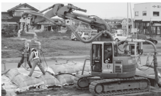
写真—11 圧送されたヘドロの充填
