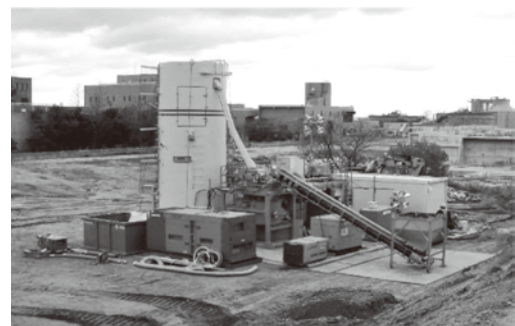
写真一八 気泡混合土製造現地プラント
