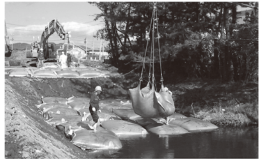
写真—12 可搬型袋の運搬と設置
