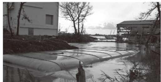
写真—13 定置型袋を用いた盛土
