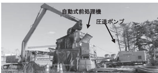
写真—10 浚渫土の前処理とポンプ圧送
