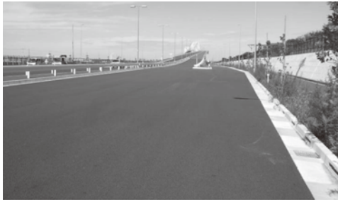
写真一七 完成時の状況 (H23.8.30撮影)
