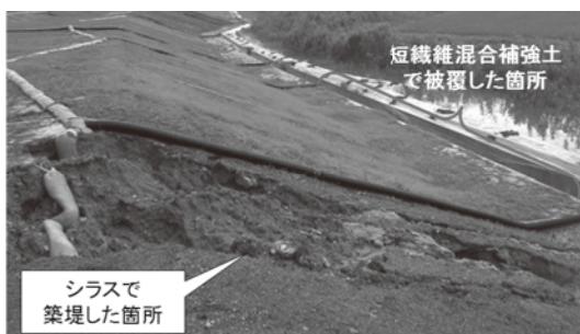
写真—15 シラスを用いた短繊維混合補強土（施工後3ヶ月）
