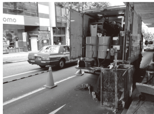
写真一九 作業帯内での注入状況
