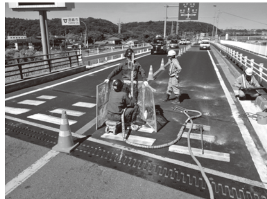
写真一八 踏掛版下への注入状況
