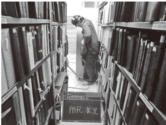
写真—2 狭小部での削孔・集塵状況
