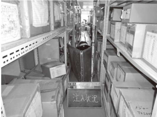
写真—1 狭小部での注入状況
