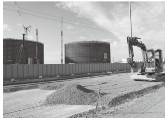
写真一 3 八戸港改修道路工事 (工期: 2012/3 ~ 9)
