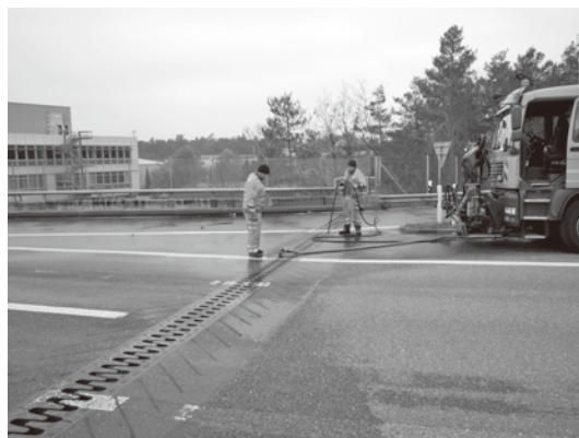
写真一十 遊間に設置された樋の清掃 (スイス)
