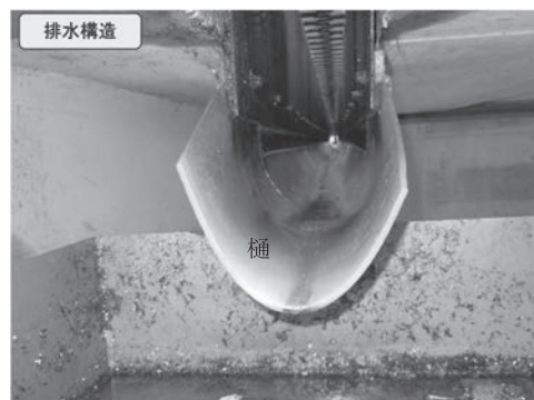
写真-4 フィンガージョイント排水構造
