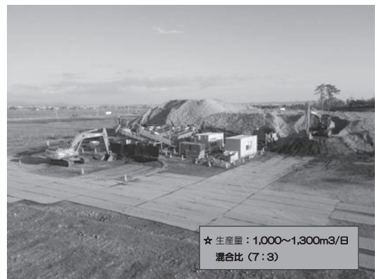
写真-4 改良土製作プラント全景
