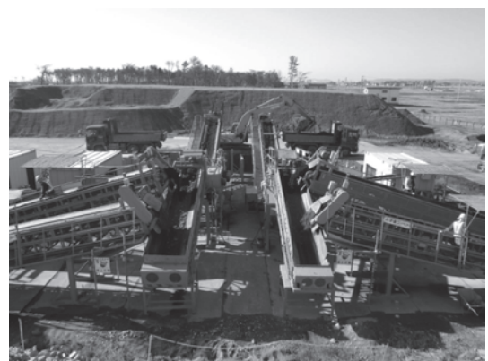
写真-5 混合機械稼働状況
