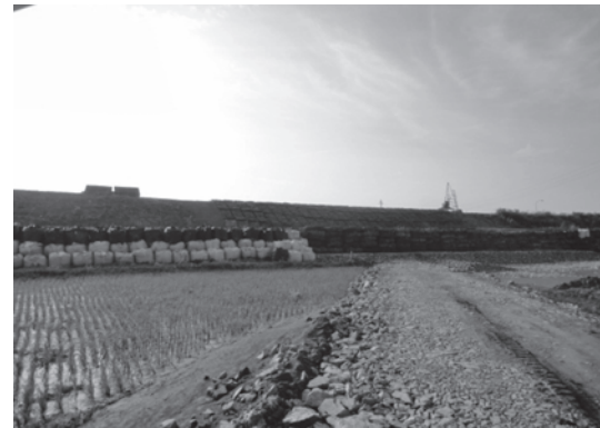
写真—7 さらなる堤防安定化のための応急復旧完了（7/22 22:30）
