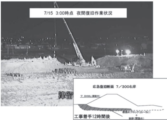
写真—3 工事着手 12 時間後の状況
