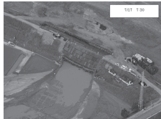
写真—6 応急復旧完了（7/17 7:30）
