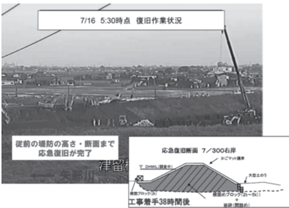
写真—4 工事着手 38 時間後の状況 従前の高さ、断面までの応急復旧完了
