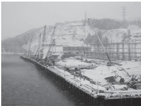
写真—18 4台同時の棧橋架設作業
