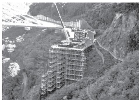
写真—2 在来工法によるダムサイトの栈橋工
