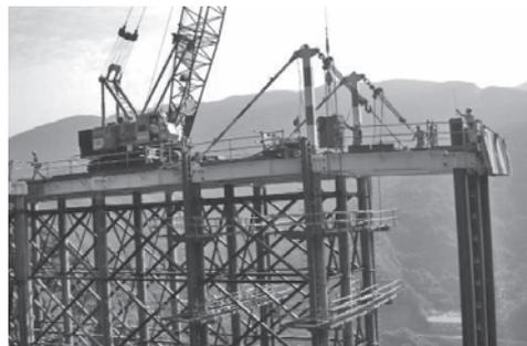
写真—1 「本工法」による栈橋架設工
