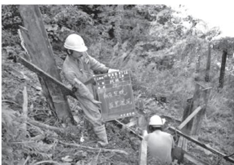
写真一五 導材（導杭・導枠）設置工（急斜面）
