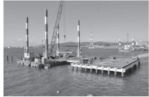
写真—14 SEP上クレーンによるパネル架設
