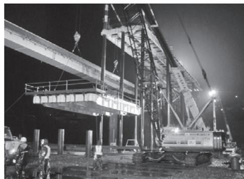
写真—21 深夜・雨天中のパネル架設
