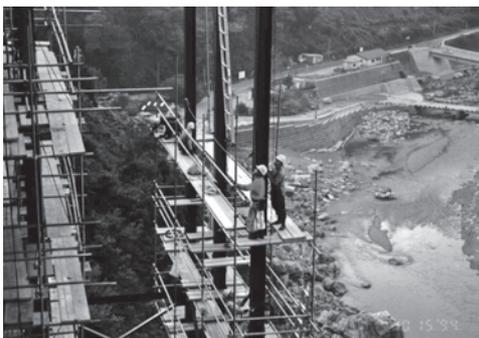
写真一三 下部工架設作業（はしご吊り下ろし）
