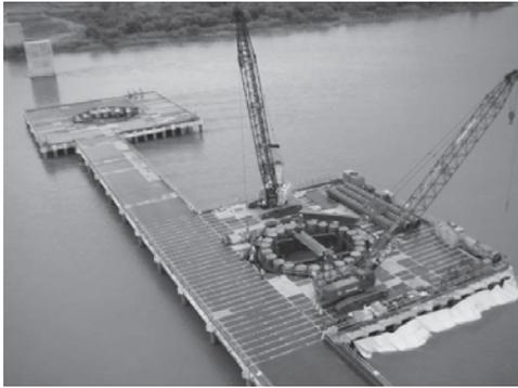
写真—12 2つの井筒基礎を施工する作業構台
