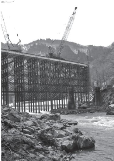
写真—17 鉄道橋構築のための棧橋工
