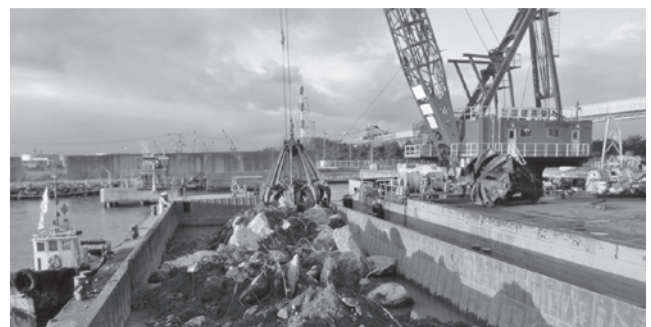
図一6 破砕コンクリート等陸揚状況
