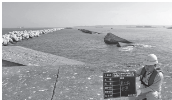
図一 3 施工前全景
