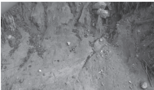
写真一12 約3m高度からの災害現場空撮
