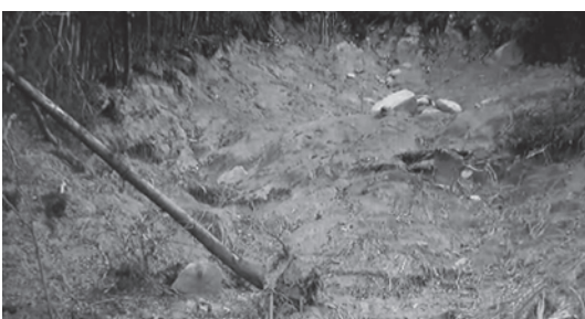
写真-6 地上カメラで撮影した災害状況
