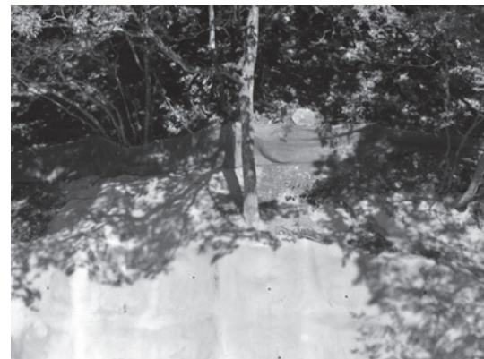
写真—18 無人飛行体 (SARA-XV) が空撮した法面工事の接近写真
