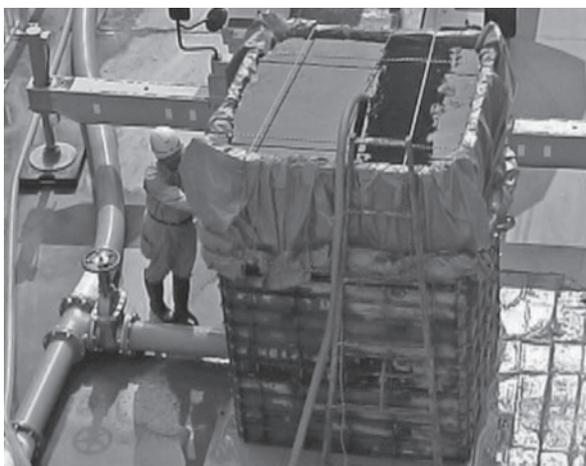
図一2 型枠用部材で組上げた仮設タンク
