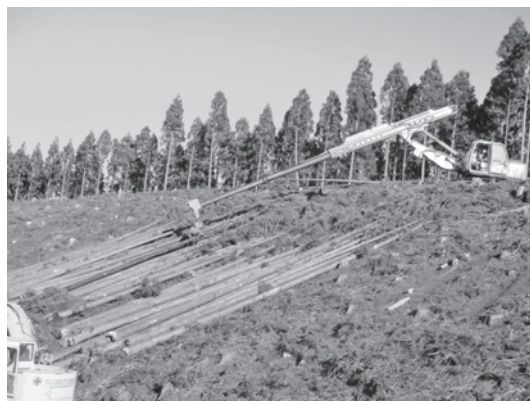
写真一八 ロングアームグラップルによる作業
