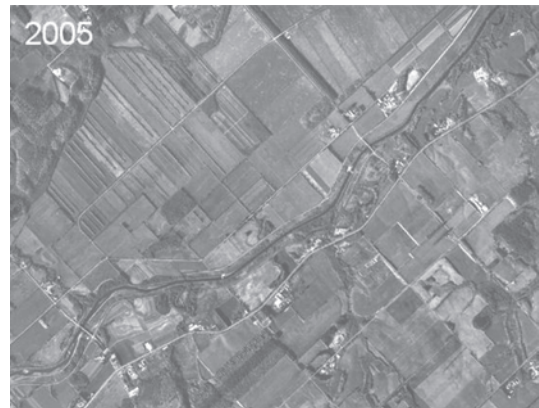
写真一3 標津川下流域の河道直線化
